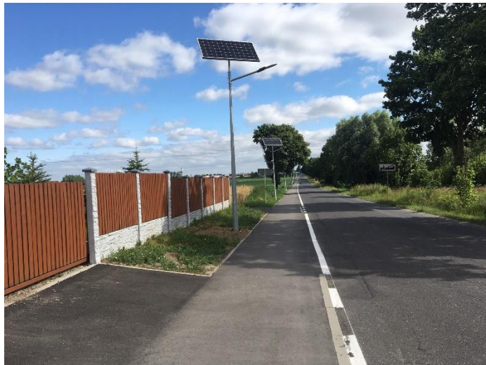
Ścieżka rowerowa w Lednogórze
